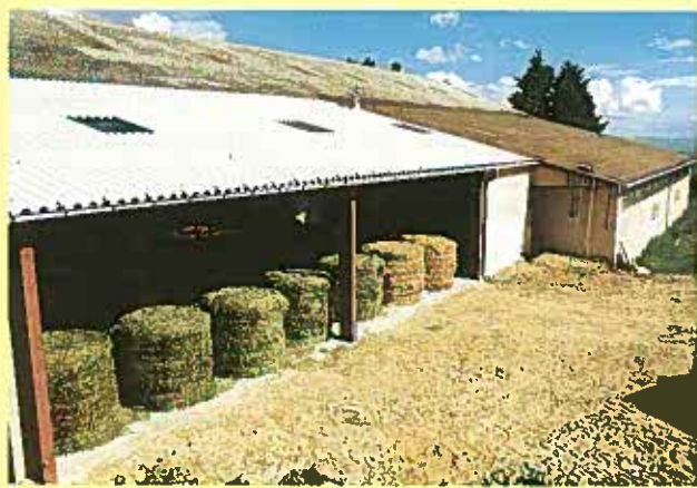
Photo 4 : Exemple d'un séchoir solaire pour 35 balles rondes avec appoint fioul. Aveyron (France) - 1995 - Au premier plan, l'appentis du séchoir; à droite, la bergerie récente dont la toiture constituant le capteur solaire (270 m 2 ) a été colorée au sulfate de manganèse. Derrière, la vieille bergerie toujours utilisée.
