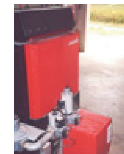
Chaudière Biogaz sur cave vinicole pour le chauffage des effluents
