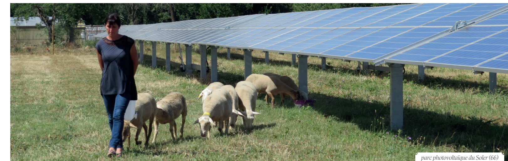
parc photovoltaïque du Soler (66)
