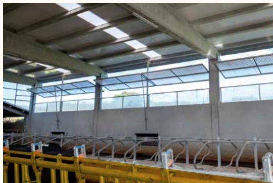
FIGURE 32. Exemple de ventilation passive. Source : Calidad Pascual.
