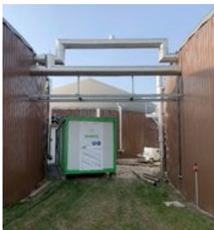
Figure 36 : Photo du système Biobang® installé sur l'une unité de méthanisation Reims Biométhane (Biobang, 2021).
