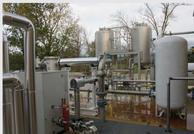
Biométharn (Tarn) : poste de traitement du gaz pour son injection dans le réseau
