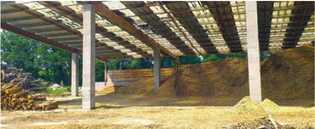
Plateforme de stockage de plaquettes de bois.
