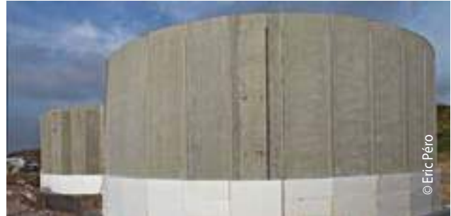
CLER VERTS, un chantier qui avance à grand pas.
