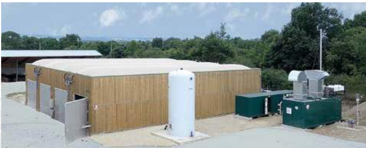
St Georges Méthagri (Maine et Loire, 49) - Le chantier de la première unité de méthanisation collective en voie solide discontinuée s'est achevé courant 2015 pour engager la période de mise en service.
