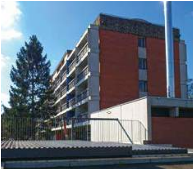
Chaufferie de la cité universitaire Fauché, Toulouse
