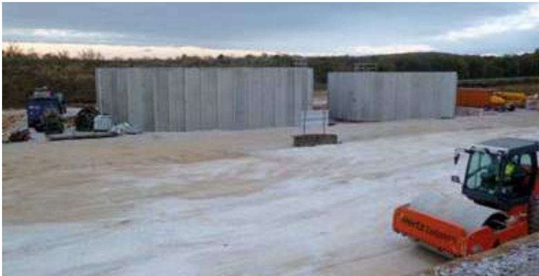
CLERVERTS (Belesta en Lauragais, 31) - Novembre 2015, le génie civil des ouvrages de digestion est achevé, l'installation commence à prendre forme.
